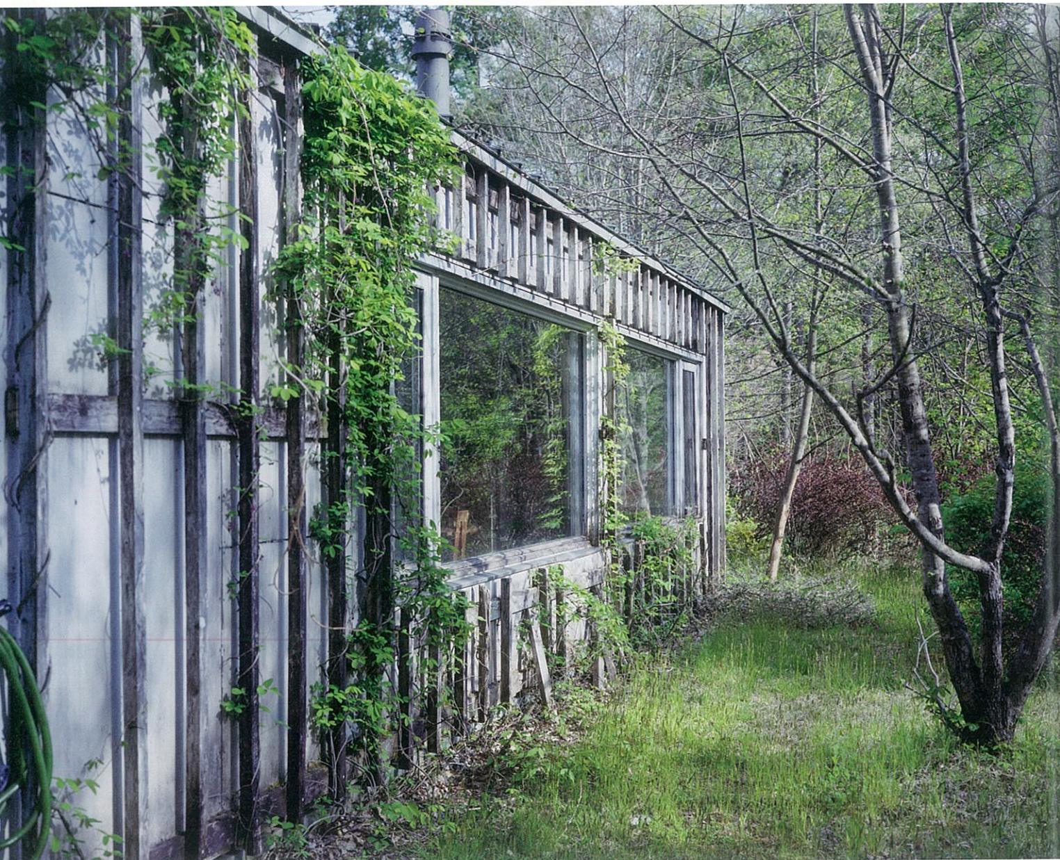
本館の外壁には木格子が取り付けられ、自生するツルマサキなどを誘引。日差しや湿度による環境負荷を軽減している。竣工から20年経って植物に覆われ、風景の一部となっている
