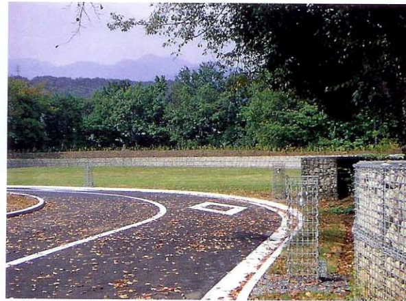
左/敷地西端の外周土塁。右手前はメッシュカゴに船舶用のランプをぶら下げた外灯* 右/左奥に外周の垂直積み土塁。右手前は斜め積み土塁。最上段は表土を中詰めし、側面緑化している。土塁地際にはつる性植物が植えられている
