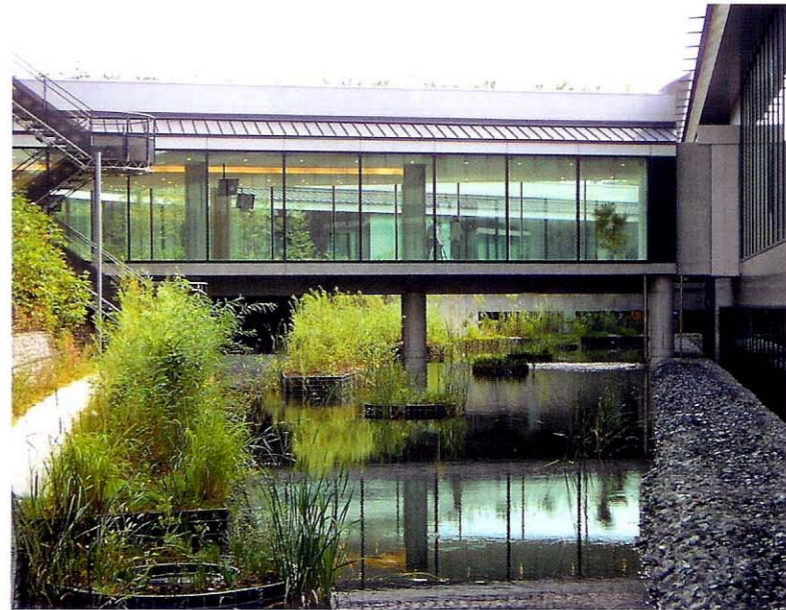
右上の庇の突起がオフィス棟の屋根の雨落ち。左手が厚生棟。正面が両棟とをつなぐブリッジ。 水面の円形状の設置物がポンプピット*
