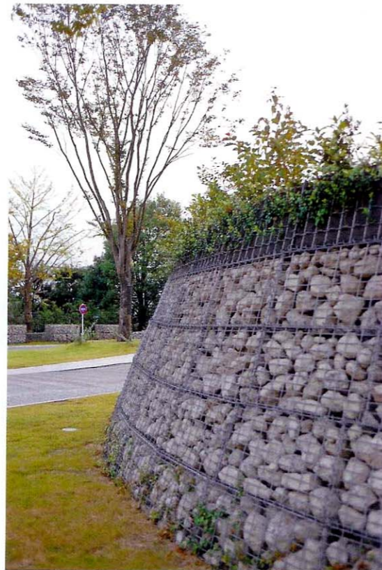
左/敷地西端の外周土塁。右手前はメッシュカゴに船舶用のランプをぶら下げた外灯* 右/左奥に外周の垂直積み土塁。右手前は斜め積み土塁。最上段は表土を中詰めし、側面緑化している。土塁地際にはつる性植物が植えられている
