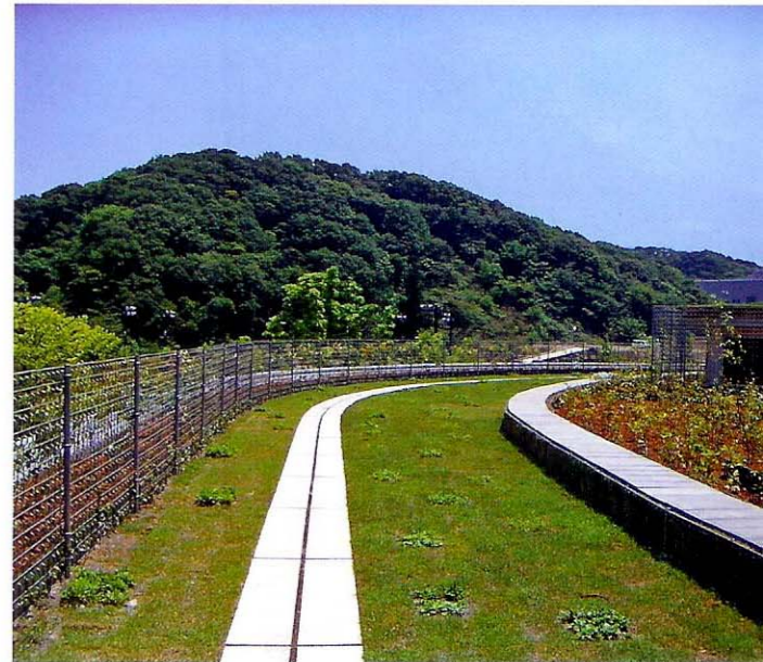
厚生棟屋上(ノースガーデン)。通路(回遊路)は万年堀板敷。右手は緑の腰掛け*
