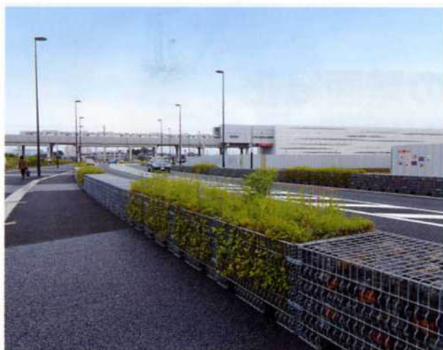
キューブ型ユニット(トラフィックキューブ)を使ったガードレール(つくばエクスプレス柏の葉駅キャンパス前)
