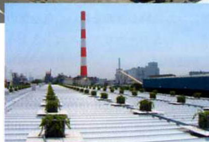
2004年に竣工した新東京郵便局の屋上にキューブ型ユニットを点在させて緑化。ドット式と呼ばれるこの手法は、現在、日本郵政公社と共同で特許出願中
