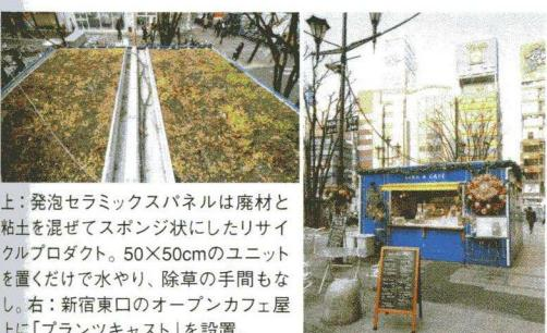
上: 発泡セラミックスパネルは廃材と粘土を混ぜてスponジ状にしたリサイクルプロダクト。50×50cmのユニットを置くだけで水やり、除草の手間もなし。右: 新宿東口のオープンカフェ屋上に「プランツキャスト」を設置。
