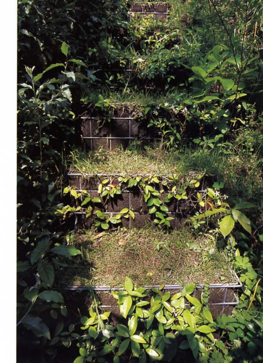
斜面の左端に配した階段は、5×緑ユニットだけで構成されている。地表の植生を傷つけないよう、吊り階段状に組み合わせて地面に乗せているだけ。草を踏みしめて歩くのが気持ちいい。
