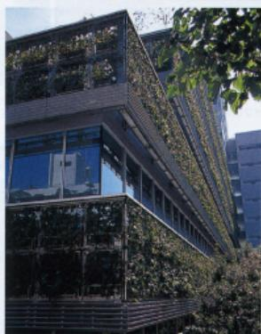
二番町ガーデン（設計：三菱地所設計）ではオフィス西側の壁を壁面緑化パネル（東邦レオ）で緑化した。0.9×0.9mのステンレス製ユニットにヘドラカナリエンシスをはわせている（写真：本誌）
