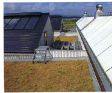
屋上のバッシブ蓄水技術。ソーラーパネル、草屋根、ベトナム
