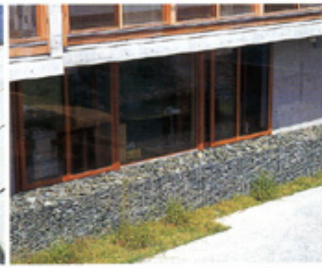
事務棟南側。石詰めのアースワークには、カニが潜みついた。いずれも植物で覆われ、保水するバッシブウォールとなる
