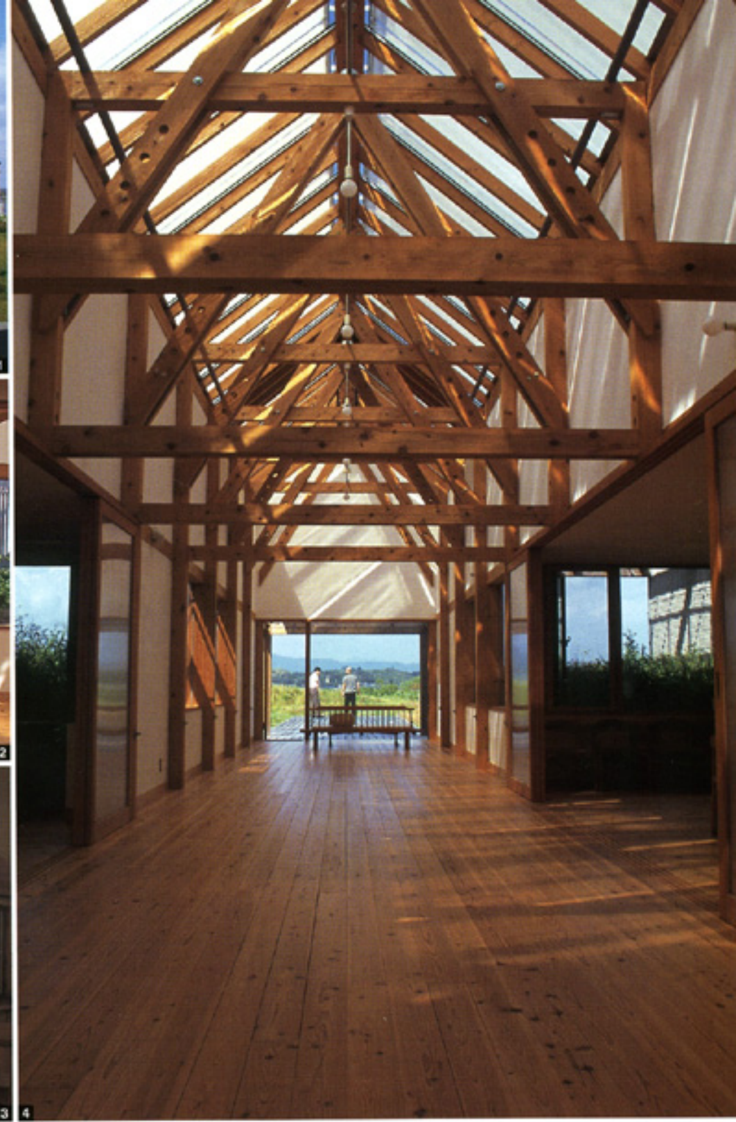
1 エントランス周リ。アースワークで、対面道路2階へもアプローチできるようにしている。2 コリドールからアルコーブ（フリースペース）、中庭の眺め。3 カフェテラスからは浜名湖が一望できる。4 南北に貫通するコリドールから池を望む。屋根のスクリーンを流れる水が涼しげな影を落とす
