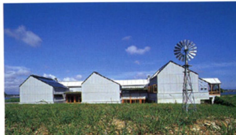
建物西側。手前の盛土部の苗木が成長すれば建物は森の中に沈む。写真/上田明
