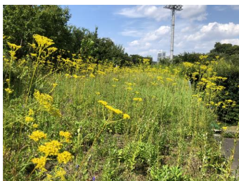
8/27 トイレ棟草屋根の様子 オミナエシほか
